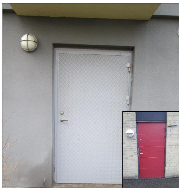
Ståldörr samt trädörr
