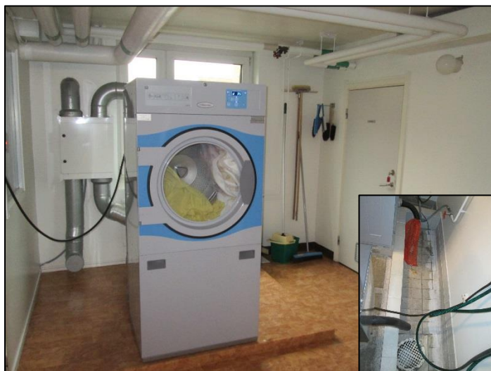
Tvättstuga med linoleumgolv samt avlopp TM
