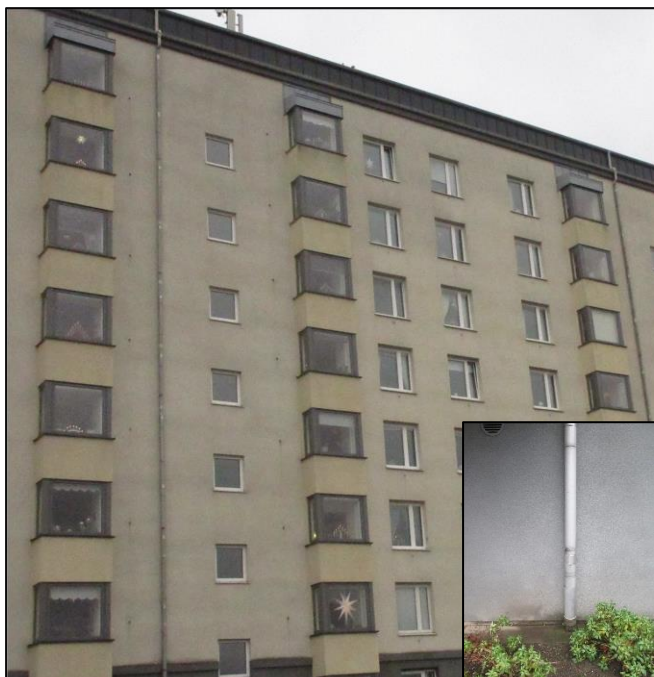
Putsad fasad med burspråk och stuprör
