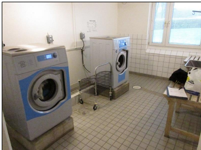
Tvättstuga med klinkers, kakel samt linoleumgolv
